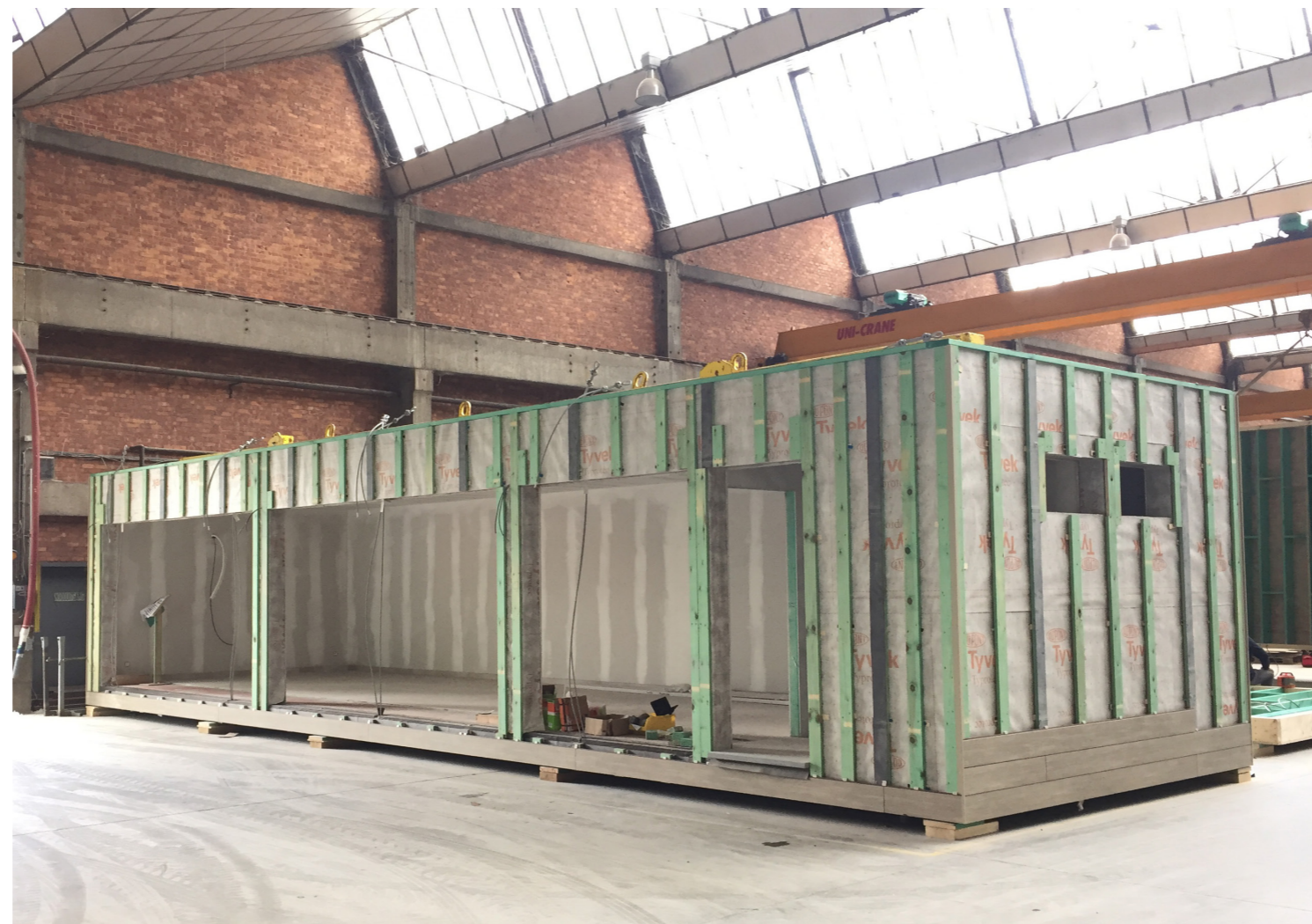
Voorbeeld van een module in opbouw. Ontbreekt de gevelafwerking.
