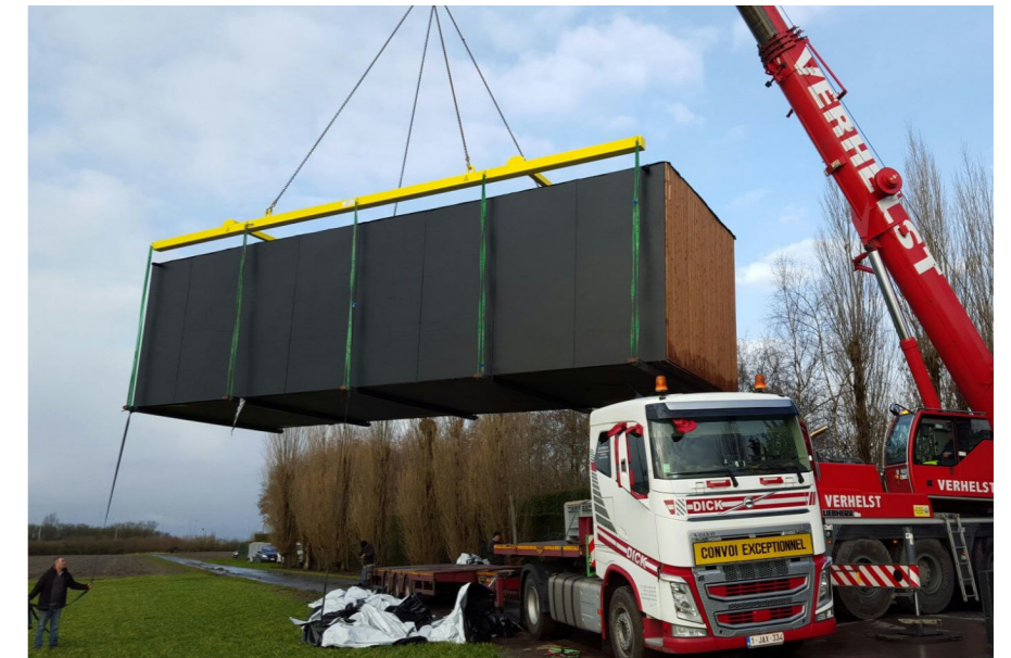
Module wordt door middel van kabels verplaatst met een kraan.
