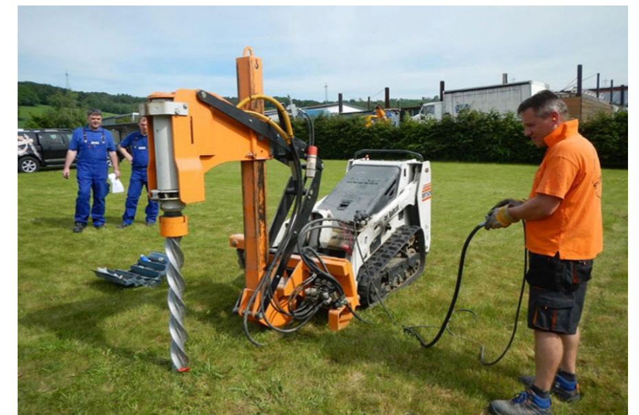
Schroefpalen worden machinaal geplaatst.
